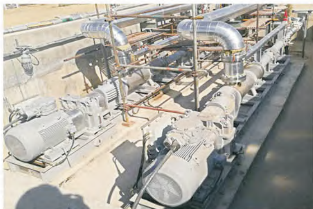
Насос с подшипниковой коробкой транспортирует нефтегазовые смеси
