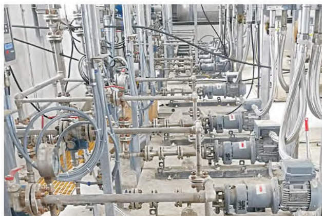
Дозирующий насос транспортирует реагент для химической промышленности
