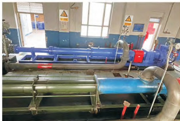
Моноблочный насос транспортирует нефть, содержащую воду
