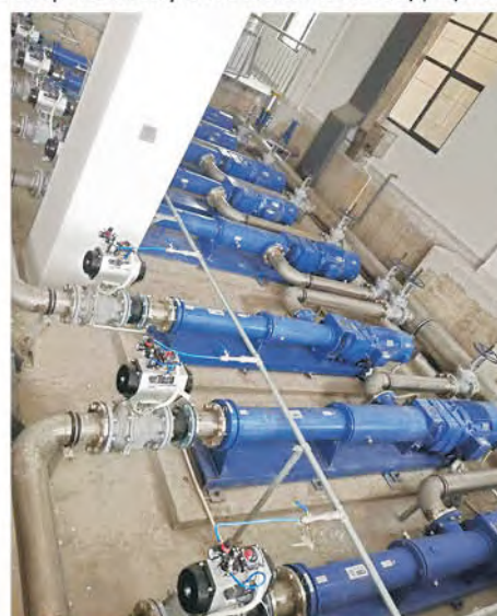
Моноблочный насос транспортирует сточные воды от красильного процесса
