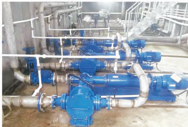
Моноблочный насос с разрезателем перекачивает городские сточные воды
