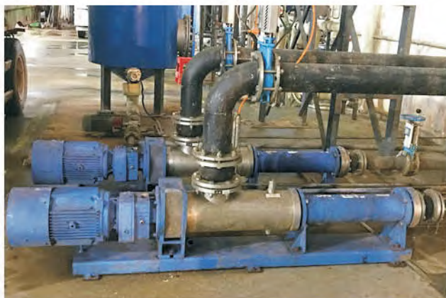
Моноблочный насос транспортирует смесь кухонных отходов
