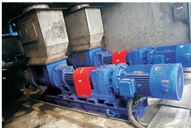
Бункерный насос типа M2 транспортирует сточные воды от обезвоживающего процесса
