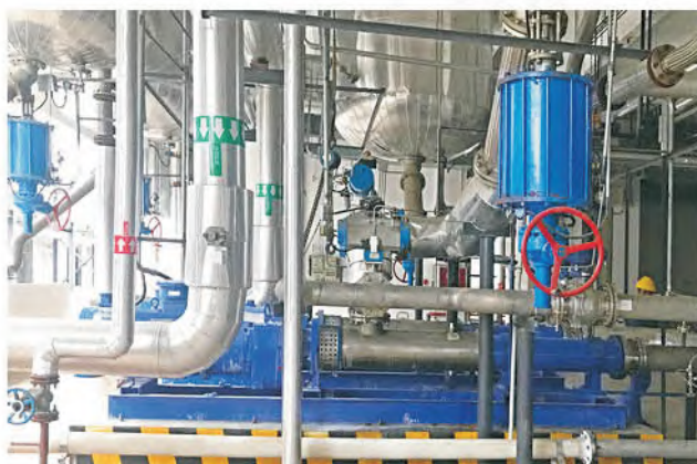
Моноблочный насос транспортирует раствор PVA
