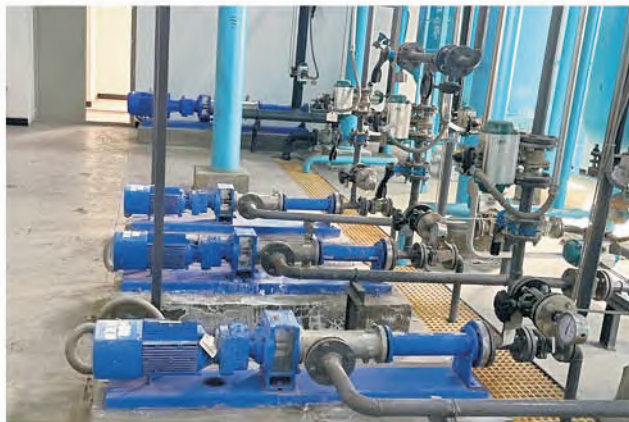
Дозирующий насос транспортирует химические вещества
