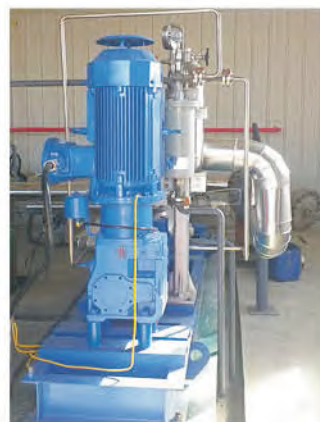
Насос с подшипниковой коробкой транспортирует конденсат
