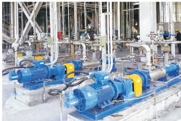
Насос с подшипниковой коробкой транспортирует массу
