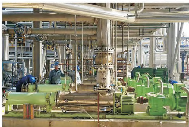
Насос с подшипниковой коробкой транспортирует химическую массу
