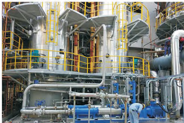
Насос с подшипниковой коробкой транспортирует массу аминокислот
